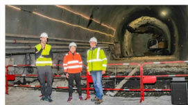
Au bord du tunnel de base du Mont-Cenis. De gauche à droite : Jérôme Ponce (PR chantier TELT), Dominique Boudier (responsable communication) et Xavier Desmard (directeur technique TELT).
